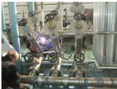
Монтаж испытательных вакуумных камер
